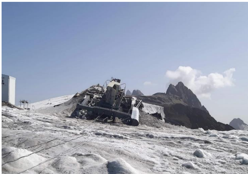
Photo 3 : Gare amont du téléski du Dôme Sud écrasée – Source : Deux Alpes Loisirs, 2019
