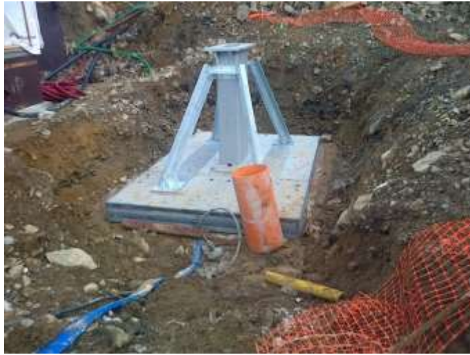
EMBASE METALLIQUE SANS FONDATION BETON
