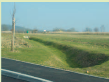
Noue de collecte de ruissellement diffus amont
