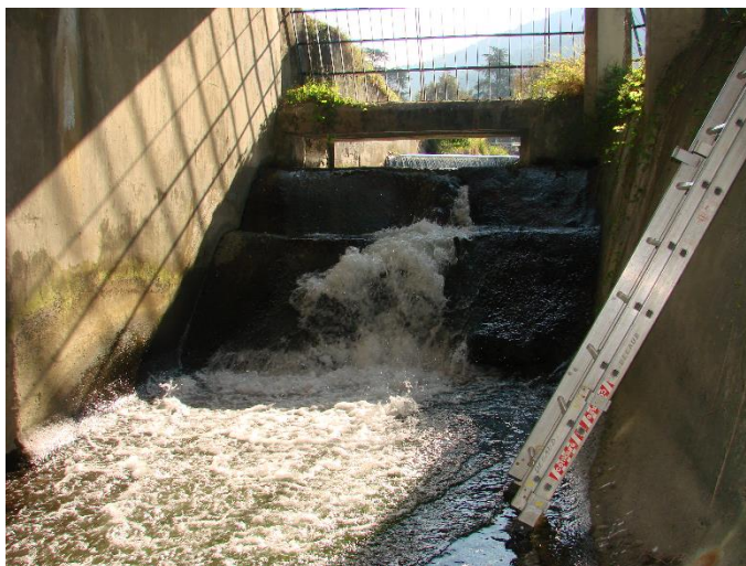
Fig. 14. Photo de l'ouvrage de vidange à réhabiliter (seuils)
