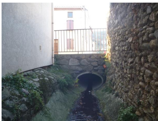
Figure 21 : Buse de traverse de la RD86 par le ruisseau de Furgon
