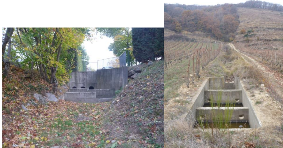
Figure 20 : Ouvrages de dissipation : ruisseaux de Saint-Jean et des Blaches
