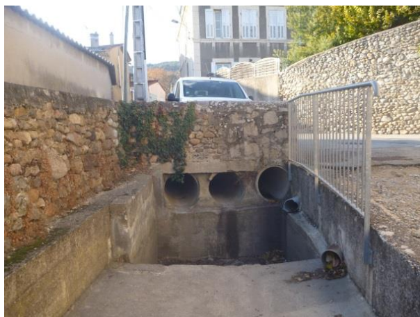
Figure 22 : Buse de traverse de la RD86 par le ruisseau de Saint-Jean
