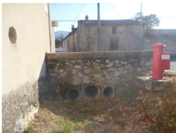
Figure 23 : Buse de traverse de la RD86 par le ruisseau du Mollard
