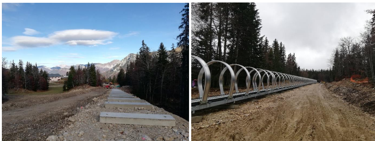
POSE DES TRAVERSES PUIS DE LA STRUCTURE DU TAPIS - TAPIS YOUNI, STATION DU MARGERIAZ (73), 2020
