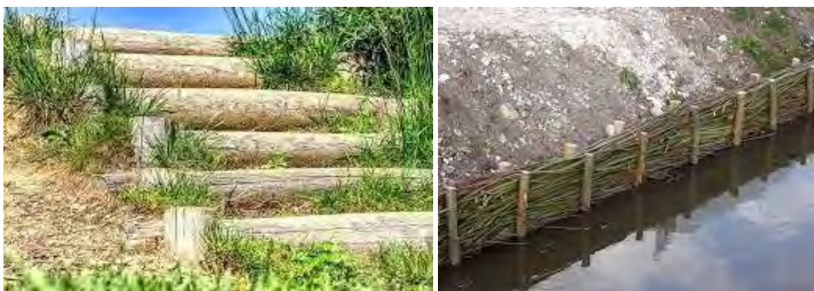
A gauche, escalier en rondins de bois ; à droite : fascine en pied de berge
