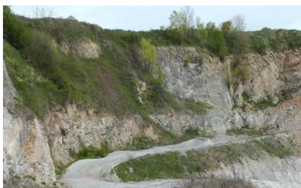
Réhabilitation des fronts de taille : principe de l'éboulis végétalisé
