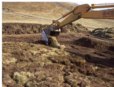
Photo 3 Exemple de remise en place de mottes à la pelle mécanique
