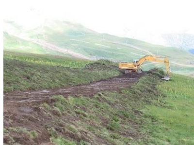
Photo 2 Exemple de stockage de mottes à la pelle mécanique en bordure d'emprise
