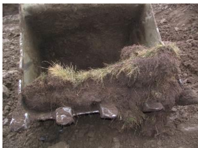
Photo 1 Exemple de déplaquage de mottes à la pelle mécanique et godet « classique »
