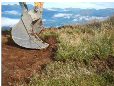
Photo 1 Exemple de déplaquage de mottes à la pelle mécanique et godet « classique »
