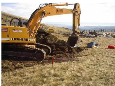
Photo 2 Exemple de stockage de mottes à la pelle mécanique en bordure d'emprise
