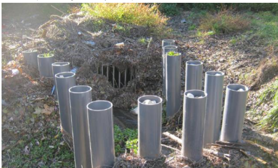
Figure 7 : Photographie des plots anti-embâcle et de la grille de protection en sortie de bassin
