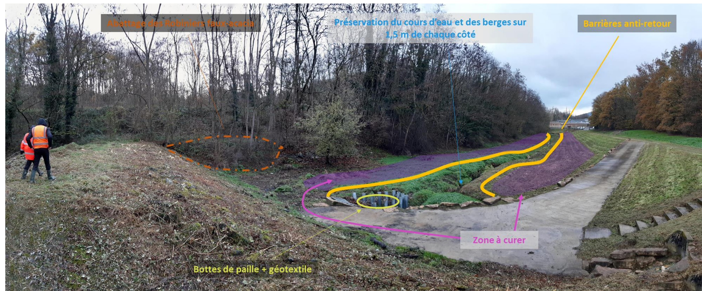
Figure 3 : Vue depuis l'aval du bassin à curer, des travaux et mesures prévues © EODD 2020
