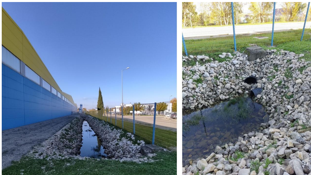
Photo 1 : Réseau EP actuelle de l'entreprise Rozier – noue connectée au réseau communal des EP
