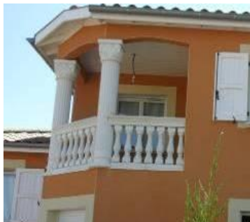
Type de balustres interdites
