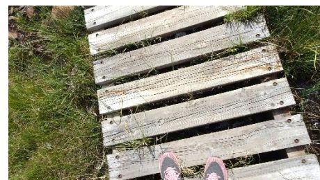
Exemple de passerelles bois ajourées, installées en zone humide _MR KARUM 2023
