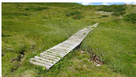
Exemple de passerelles bois ajourées, installées en zone humide _MR KARUM 2023
