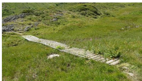
Exemple de passerelles bois ajourées, installées en zone humide _MR KARUM 2023
