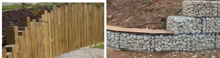
Exemple de soutènement en bois et gabions avec assise bois
