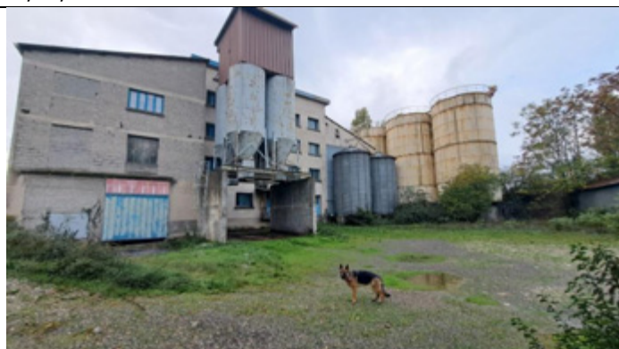
2 -Au nord du bâtiment : trémie, silos, rejets de poussières.
