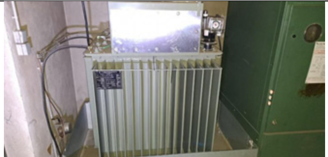
Local transformateur, commun avec celui de la ville. Il date de 2014. L'ancien contenait 100 l de PCP et a été déposé alors (recyclage non tracé).
