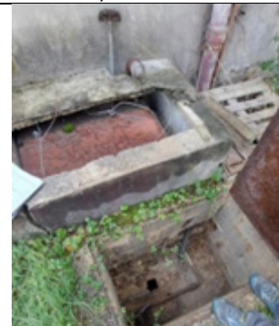
Cuve à fuel de 500 l pour la chaudière avec sa conduite sous le sol de la piste qui devra être supprimée, après inertage et vidange. Et à proximité, 2 cuves enterrées de 3000 l qui contiennent chacune environ 200 l d'émulsion : l'eau de pluie s'introduit dans les cuves à partir du pluvial. Une des cuves au moins est percée.
