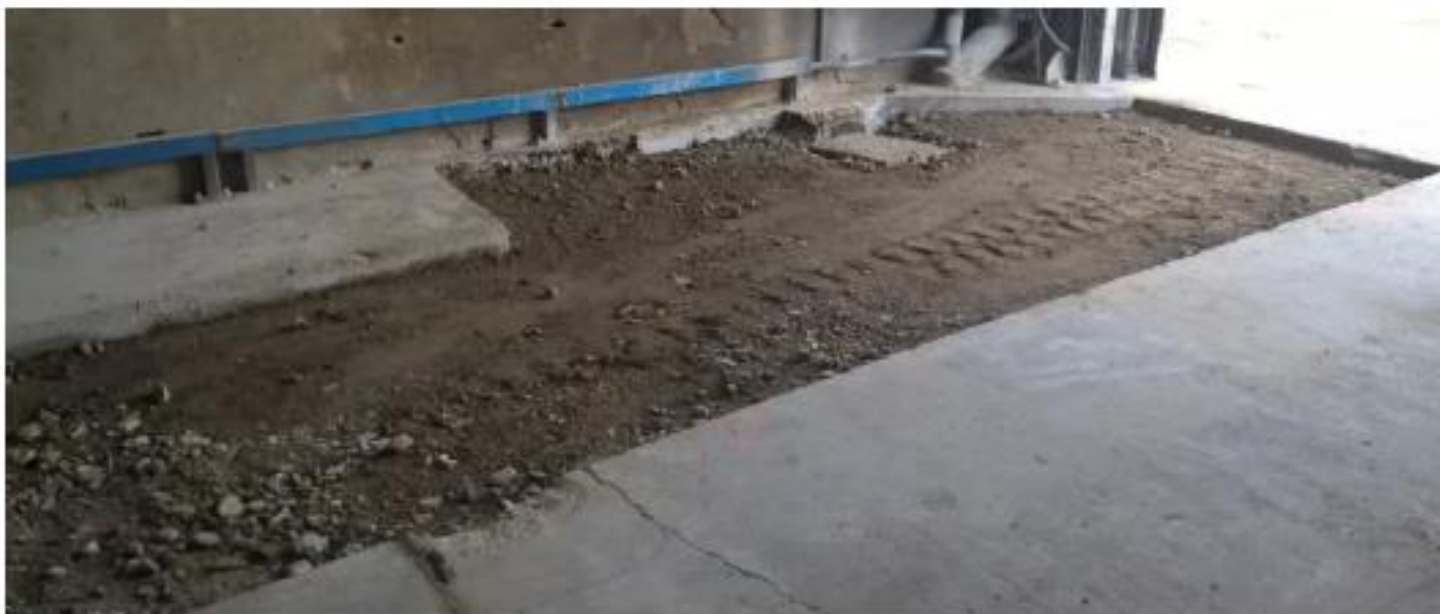
Figure 6 : Remblaiement et compactage de la zone (source : rapport SERPOL relatif à l'installation du traitement de l'ancienne station de distribution de fuel – février-mars 2017)
