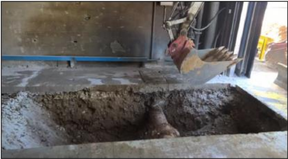
Figure 5 : Terrassement des terres polluées (zone S44) (source : rapport SERPOL relatif à l'installation du traitement de l'ancienne station de distribution de fuel – février-mars 2017)
