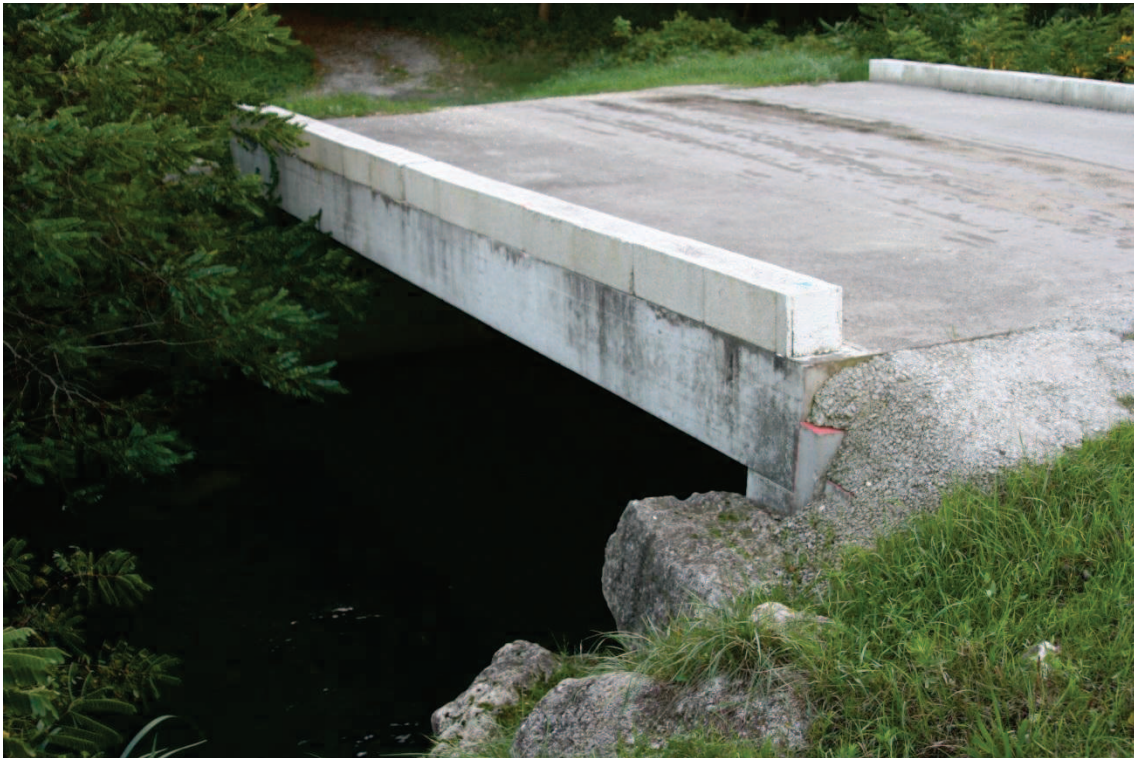
Etat projeté – modèle de pont cadre envisagé (ici sur la lône Dion ouvrage de 5 mètres de large) - commune Pierrelatte)
