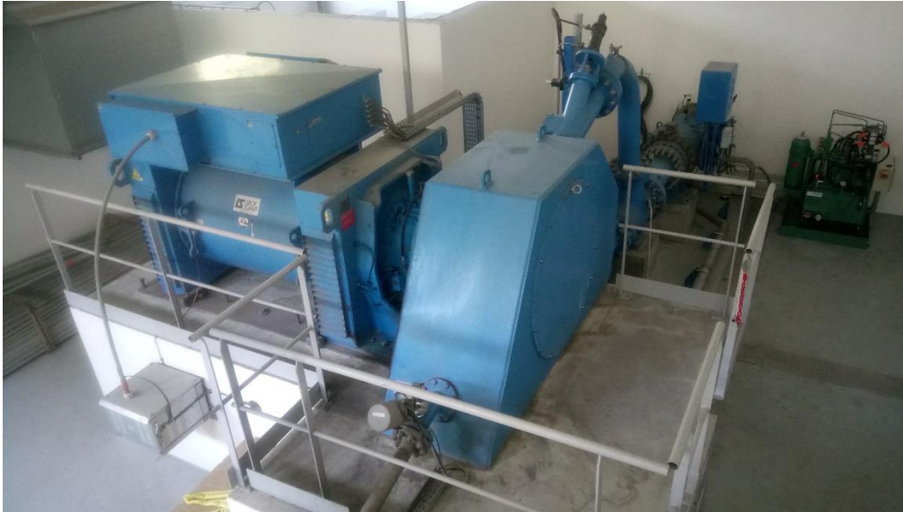
Exemple d'une Pelton 2 jets avec son alternateur (centrale des Encombres, Synergie)
