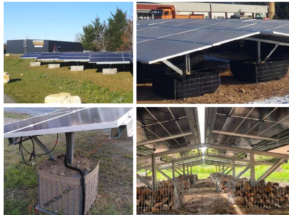
Exemple de solutions lestées commercialisées par les entreprises d'installation
