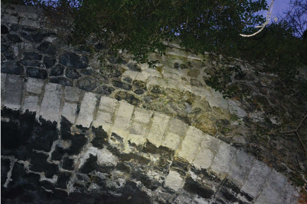
Illustration 3 : Disjointoiement localisé sur le tympan de la tête sud – Vachon
