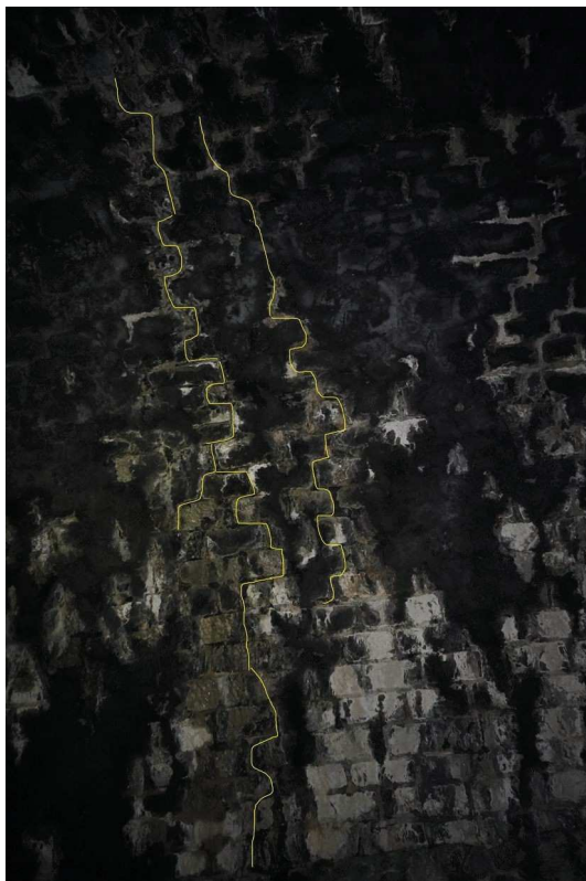
Illustration 4 : Fissure transversale ouverte sur joints et moellons en calotte ouest au PM20 (à gauche) et possible fissure sous dépôts noirs (à droite)
