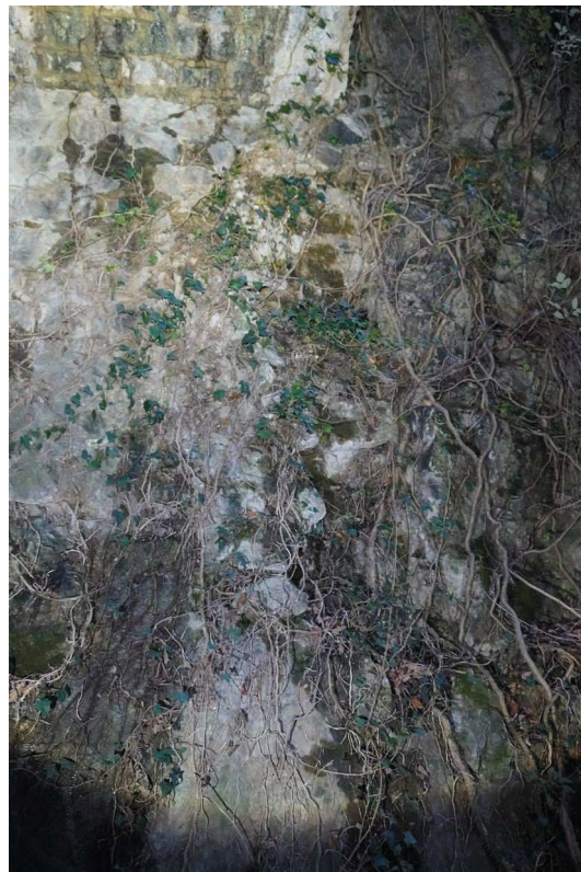
Illustration 5 : Exemple de moellons manquants sous la végétation, sur le piédroit ouest entre les PM0 et PM5
