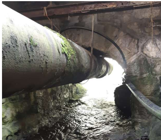
Passage de la conduite forcée sous la voirie
