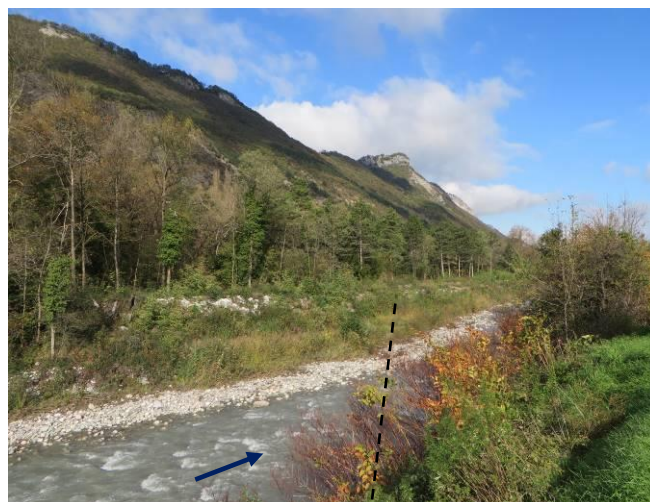
Linéaire chenalisé avec enfoncement du lit entre 2 hautes digues. Rive gauche, digue à araser.
