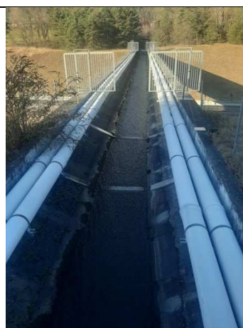
photo 4 : pont canal bétonné
