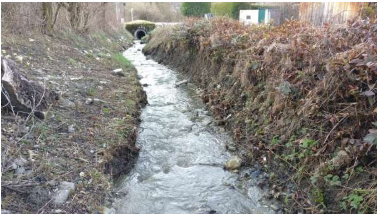
Photo n°1 – Vue sur « point dur » du profil en long : franchissement buse route départementale. A l'aval de la RD, le cours d'eau chute de plusieurs mètres (cf. profil en long annexe 3)
