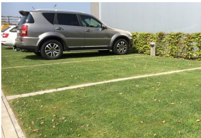
Figure 17 : Exemple de dalle gazon PEHD polyéthylène haute densité pour parking
