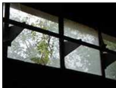
Photo N° 106--circulation-Fenêtre métal-Mastic vitre int.
