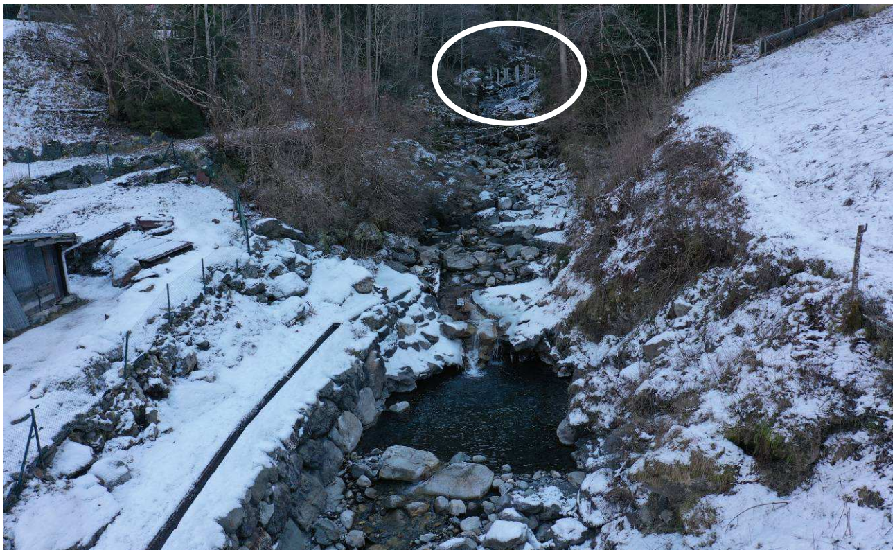
Photo 5 : Amont du cône de déjection (piège à flottant réalisé en 2015 et lit étroit).
