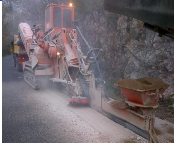
Figure 18 : Photo de trancheuse prise sur chantier
