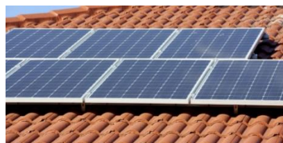
Panneaux pos  s parall  lement    la pente du toit
