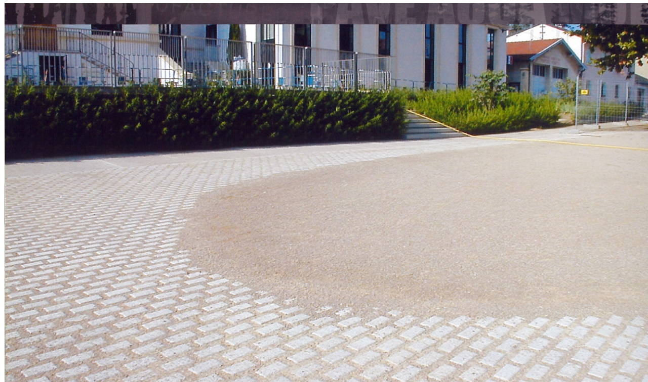
Pavé béton à joints larges, remplissage stabilisé
