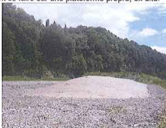
Photo 20 : Bâchage des matériaux broyés.
