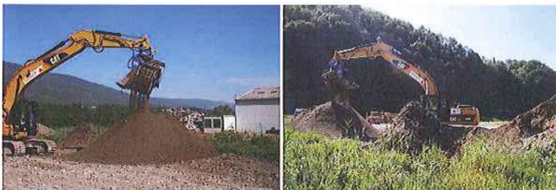
Photos 13 & 14 : Passage des sédiments dans le godet.
