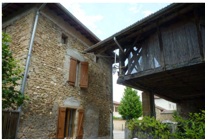
Constructions traditionnelles en moellons de molasse et ancien séchoir à noix en charpente
