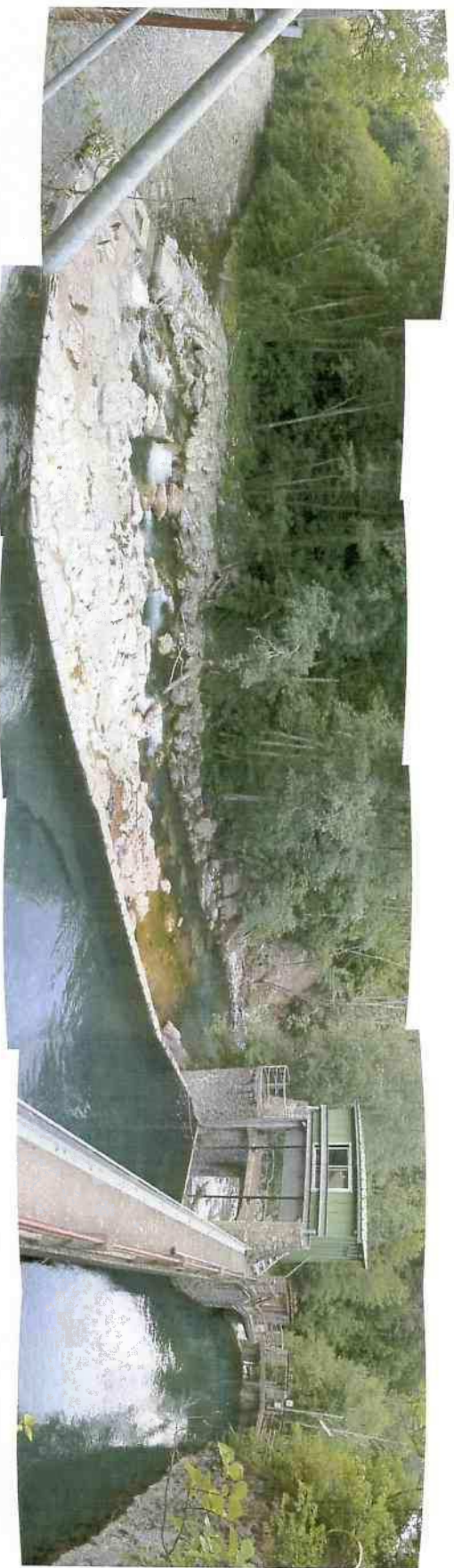
Annexe 3-3 - Prise d'eau de la centrale du Pont du Prêtre vue de la rive droite de la Bonne (point 1 de l'Annexe 3-1). Barrage avec échanturure alimentant la passe à poissons, mur déversant, vanne de barrage, bassin décanteur avec vannes de chasse.
