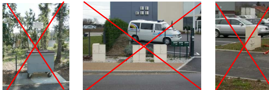
Exemples d'implantation de coffrets techniques et boîtes aux lettres non intégrés à l'opération, avec risques de dégradations car non protégés des flux véhicules.
