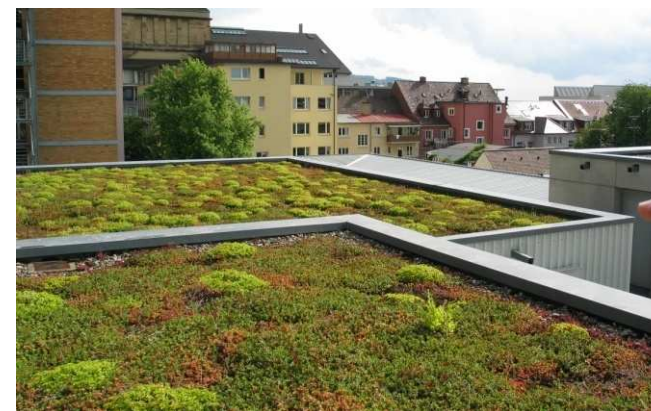
Toiture stockante végétalisée sur un bâtiment industriel
