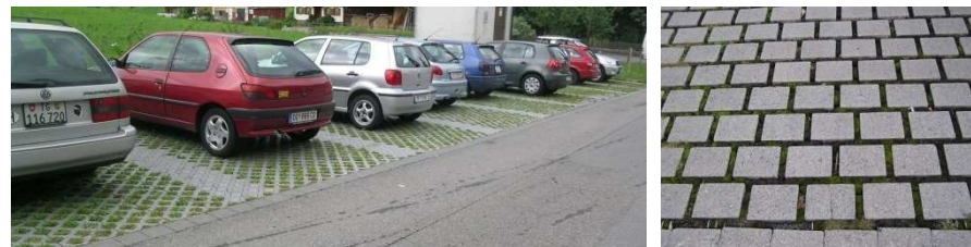
Parkings pavés drainants : Les pavés de différentes couleurs peuvent être utilisés pour baliser le trafic ou délimiter les emplacements de parking.
