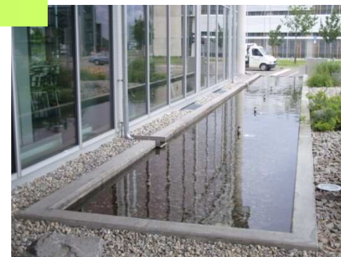
Récupération des eaux de toiture – Fribourg (All)
