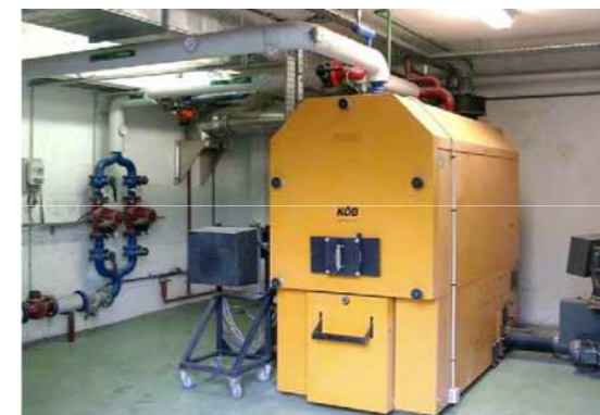
2. Chaufferie automatique au bois déchiqueté
