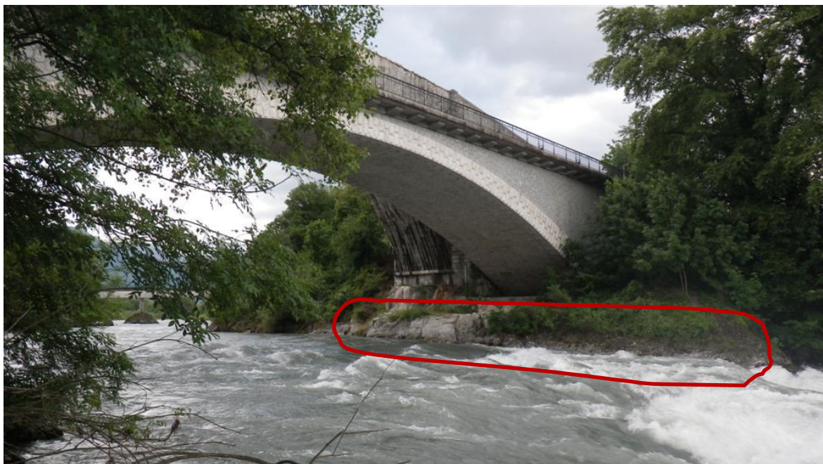
Figure 61 : Déroctage potentiel en rive gauche sous les ponts
