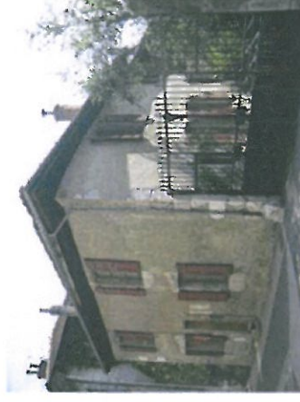
Construction en maçonnerie enduite à la chaux
