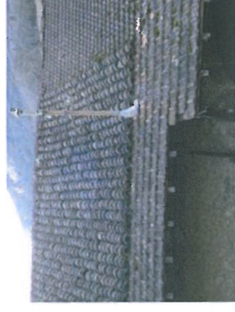
Couverture en tuiles canal
