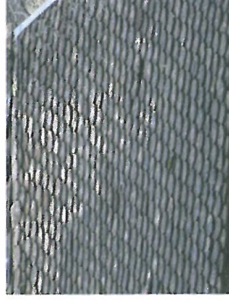
Couverture en tuiles plates
