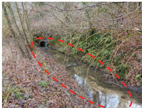
Plage de dépôt – fosse de dissipation
