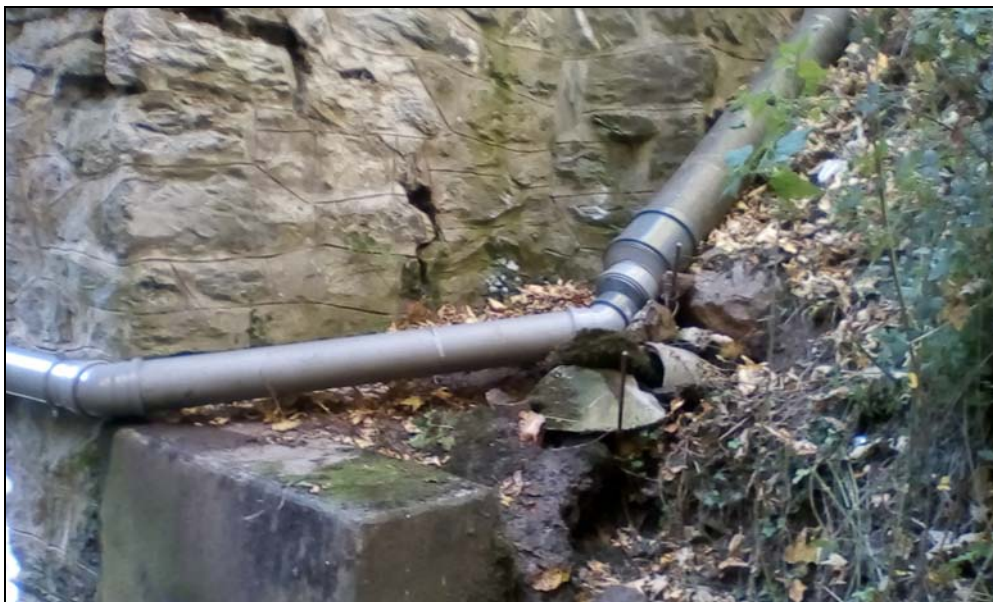
Exutoire n°2 – Le Noiret – Reprise de la canalisation de rejet afin de permettre l'installation d'un débitmètre
