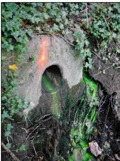
Exutoire n°3 – Montbrunal – rupture de la canalisation – présence d'érosion
