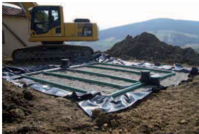
Travaux de réalisation d'un filtre à sable
