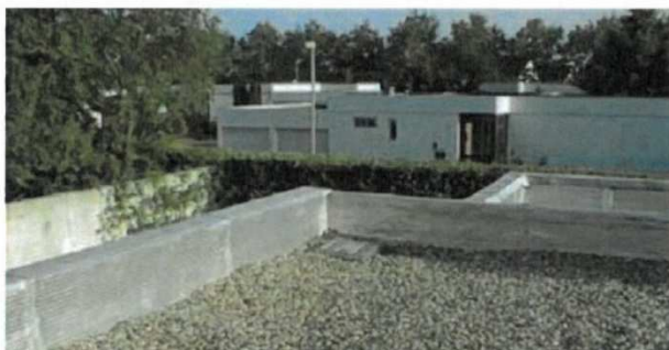
Figure 51 : Toiture-terrasse stockante (Communauté Urbaine du Grand Lyon, 2008)
