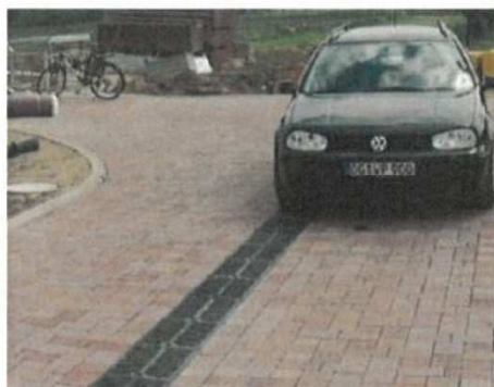
Figure 48 : Exemple de caniveau filtrant infiltrant (Funke)
