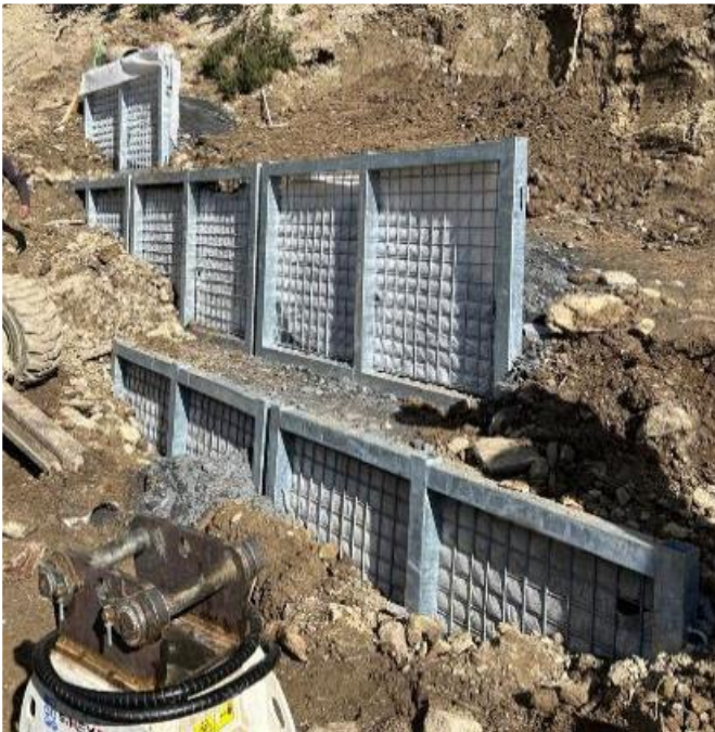
Figure 19 Photographie des modules de soutènements ANGULO® en cours de mise en œuvre
