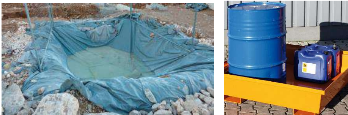
Figure 19. Stockage de matériaux polluants sur lieu étanche (à gauche) et fosse étanche de récupération des résidus de nettoyage, laitance béton, etc (à droite)
