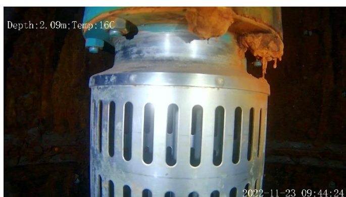
Vue de la crépine de la pompe avec corrosion des boulons
