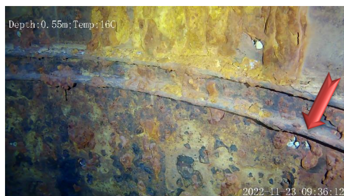
Vue plongeante du cuvelage acier avec corrosion, concrétions et perforations
