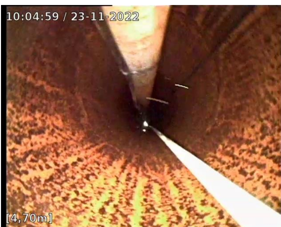
Vue du cuvelage en acier avec corrosion
