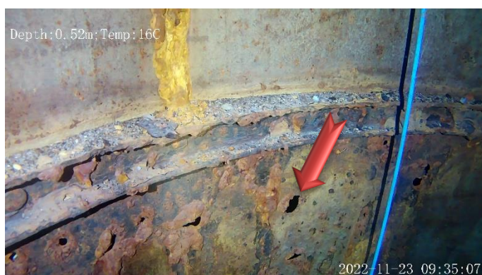
Vue plongeante du cuvelage acier avec corrosion, concrétions et perforations
