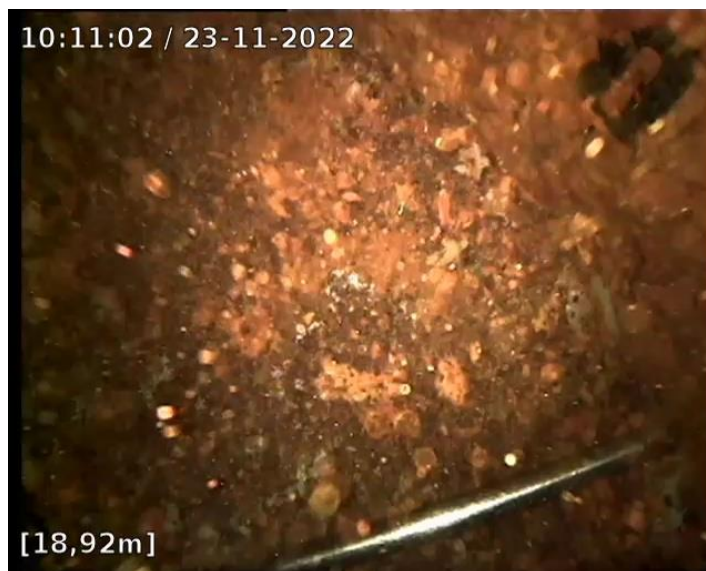
Vue du fond du puits avec important dépôt
