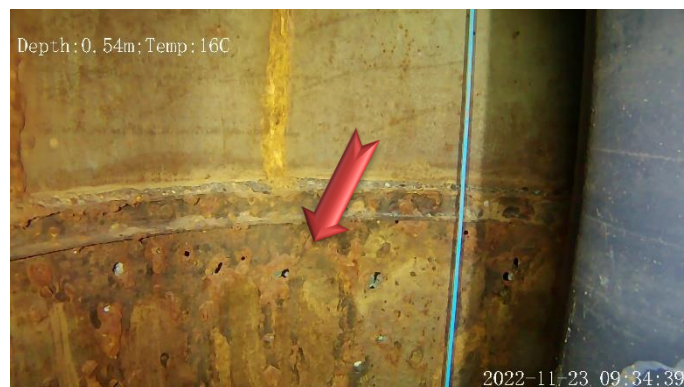
Vue du cuvelage acier avec corrosion, concrétions et perforations
