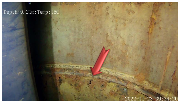
Vue du cuvelage acier avec corrosion, concrétions et perforations
