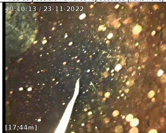
Vue de cuvelage immergé recouvert d'un important dépôt
