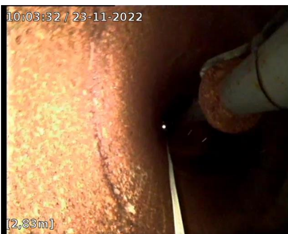
Vue du cuvelage en acier avec corrosion
