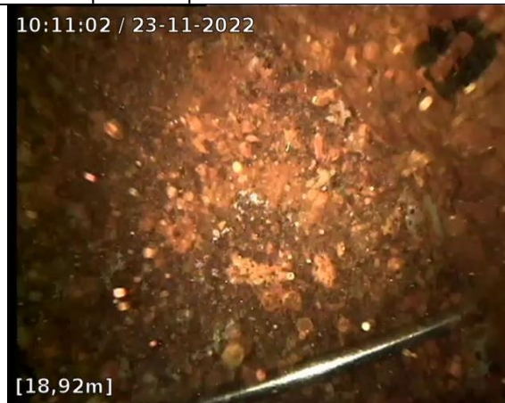
Vue des parois avec important dépôt à l'arrivée au fond de l'ouvrage
