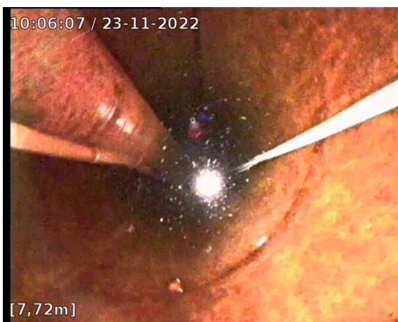
Vue du cuvelage en acier avec corrosion
