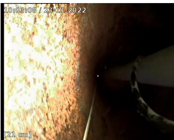
Vue du cuvelage en acier avec corrosion
