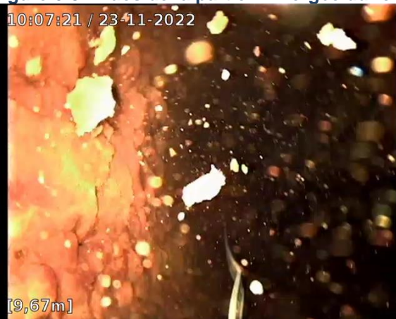
Vue de cuvelage immergé recouvert d'un important dépôt
