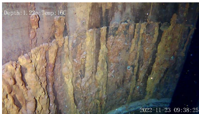
Vue d'une jonction de cuvelage avec concrétions et perforations
