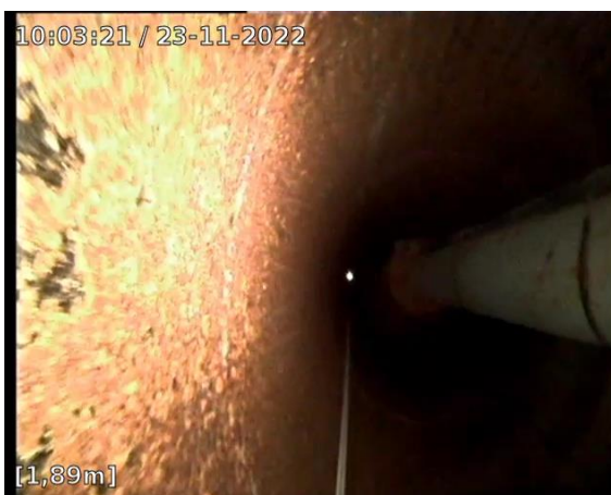
Vue du cuvelage en acier avec corrosion
