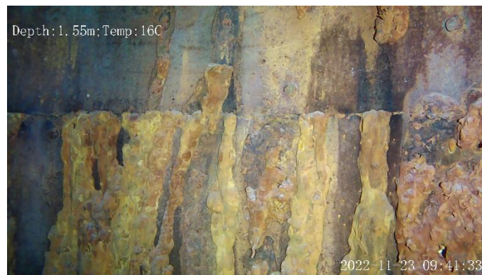
Vue d'une jonction de cuvelage avec concrétions et perforations
