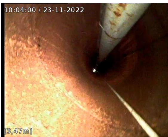
Vue du cuvelage en acier avec corrosion
