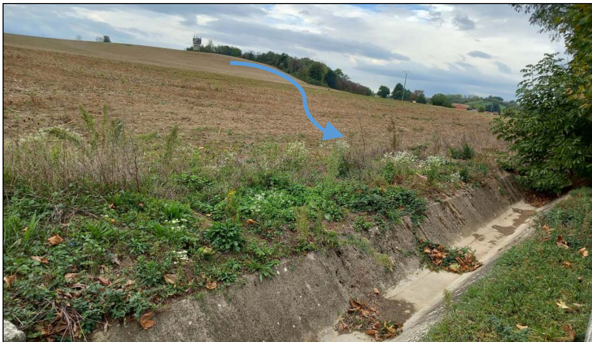
Fossé bétonné au bas du Mas
