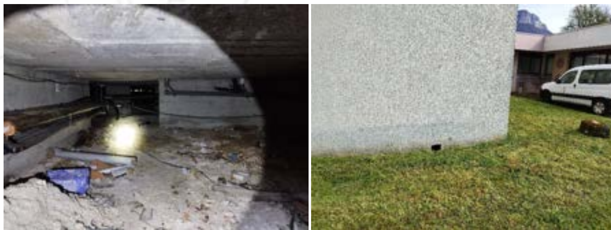
Figure 32 : vide sanitaire favorable (photo de gauche) mais difficile d'accès (photo de droite)
