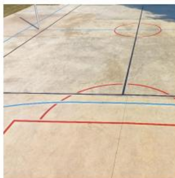
Terrain multisports en béton taloché clair à Conjux (Le sens du paysage, 2022)
