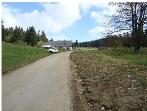
Mottes étrépees replaquées sur les surfaces de sol travaillées
