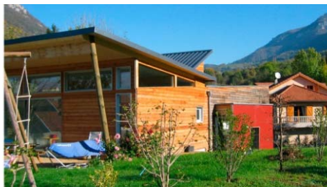
Une dépassée de toiture bien conçue permet de réguler l'ensoleillement en fonction des saisons.
