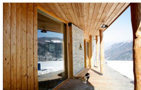
Un espace protégé sous le porte-à-faux de l'étage. Il permet une circulation abritée et sèche l'hiver vers la buanderie et la réserve de bois.
