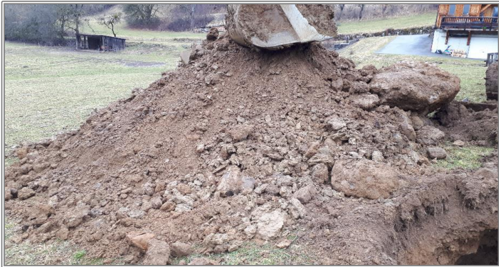
Sondage S7 et matériaux extraits
