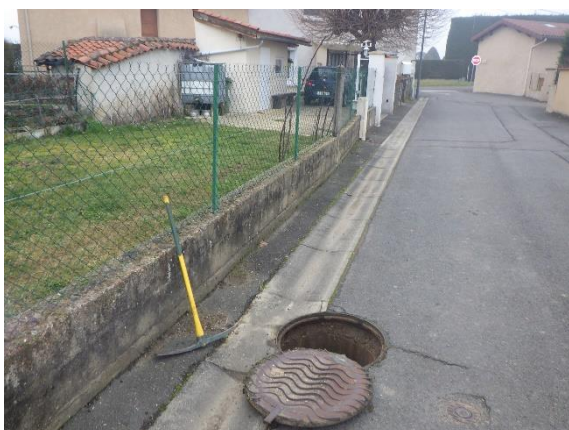
Regard de visite unitaire présentant une stagnation d'effluent – avenue Maurice Ravel – vue extérieure
