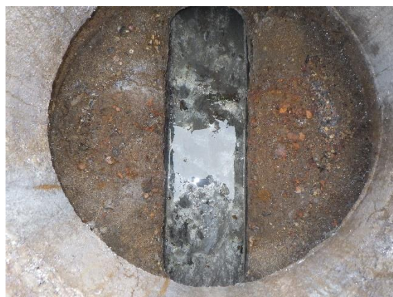
Regard de visite unitaire présentant une stagnation d'effluent – avenue Maurice Ravel – vue intérieure
